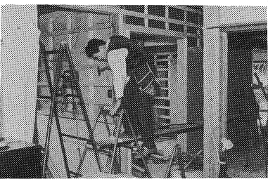
着工中の「あすなるルーム」と「うるおいルーム」(個室の病室)
