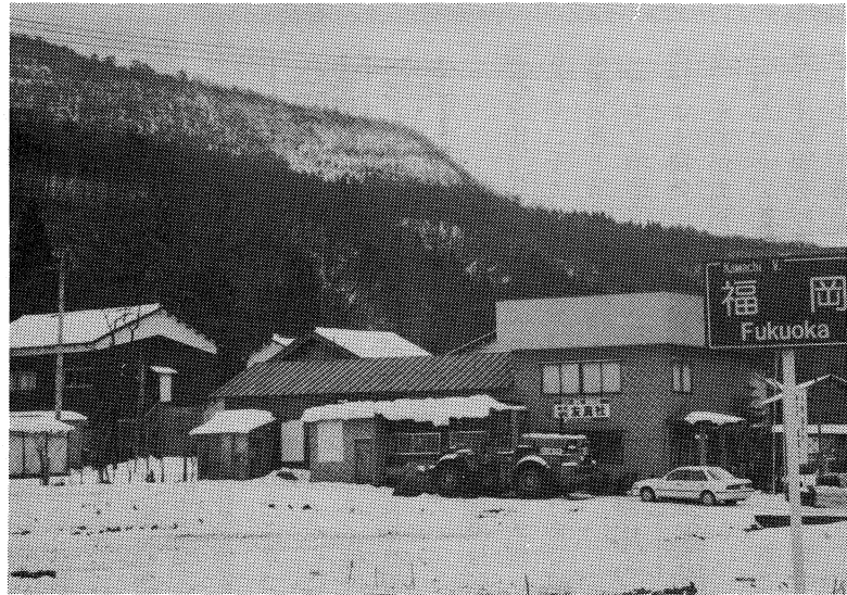
写真奥の山間部にゴルフ場建設を予定している河内村。(上水道の取水口のすぐ近く)
