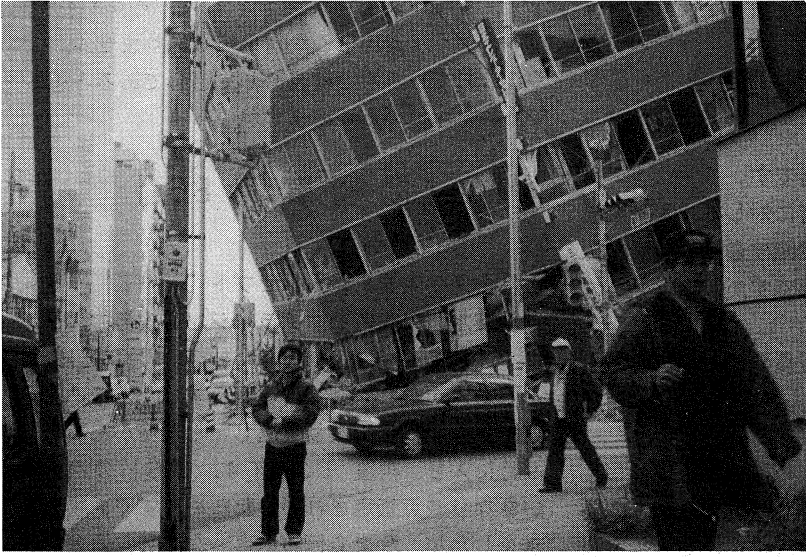
いたるところでビルが傾向している
