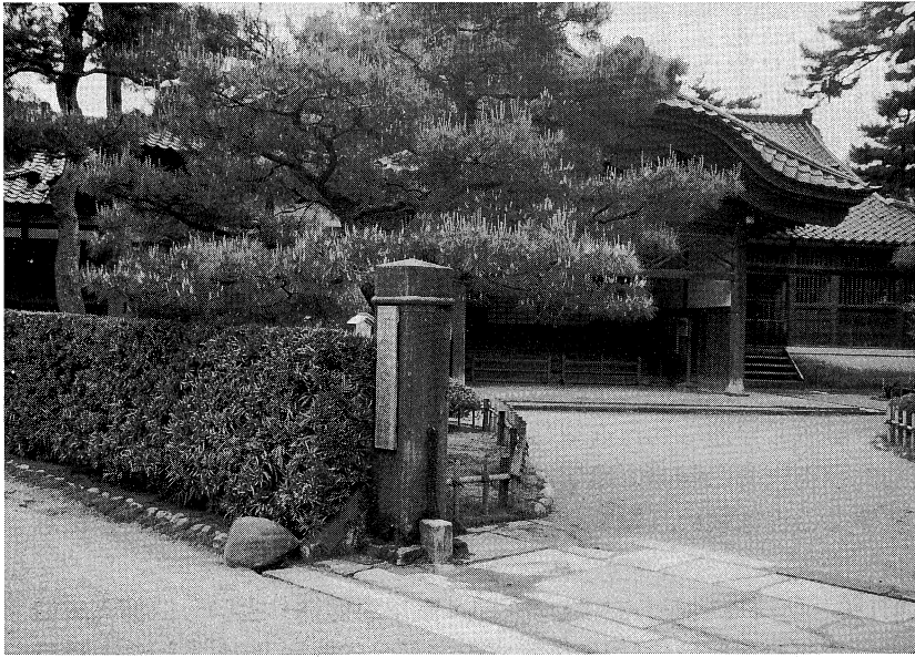
医学館玄関の遺構
