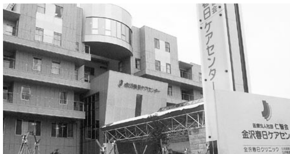
7階建てで重厚な金沢春日ケアセンター
