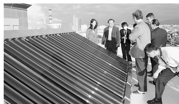
太陽熱を利用した湯沸かしシステムなど、随所に最新の省エネシステムが導入されている
