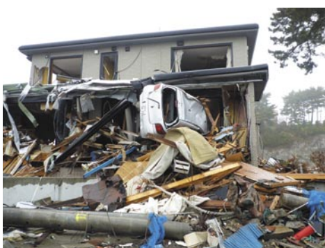
津波で流された車が家屋に激突(宮城県七ヶ浜)
