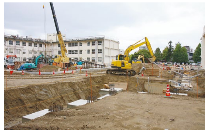
旧建物を解体し、駐車場の整備など、現在も工事が続く
