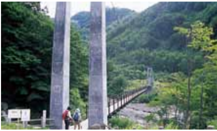
写真① 砂防新道、別当出合の吊り橋
