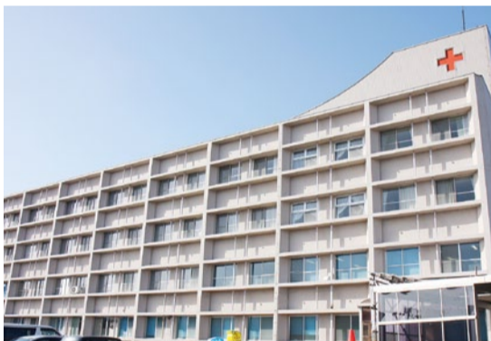
現在増築工事中の金沢赤十字病院
