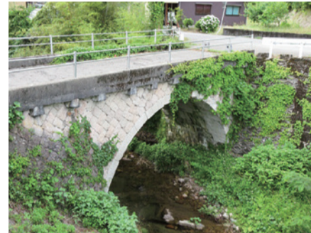
写真1 丸竹橋。違う種類の石で最近補修したか？5橋の散策の起点にしよう
