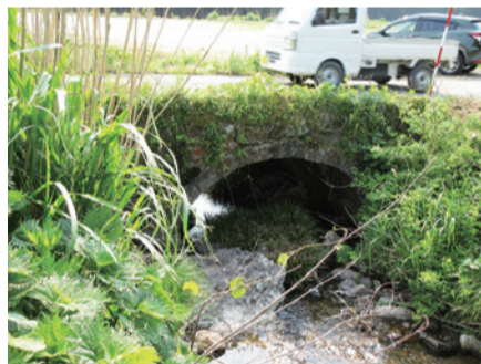
写真2 菩提町のアーチ橋。名前は不明。荷重を横方向の力に変え、支えている
