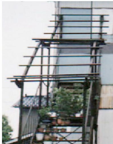
階段の登り切ったところにドアはない。途中の階段は花壇になっている
