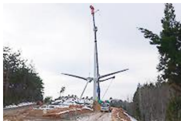
図2 ローターの取り付け作業の様子(「能登の風」HPより)
